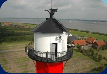
Oberfeuer Somfletherwisch an der Elbe
